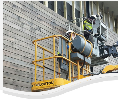
* travaux de bardage
