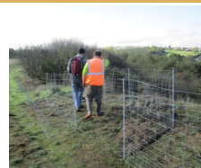
*pose de clôture
